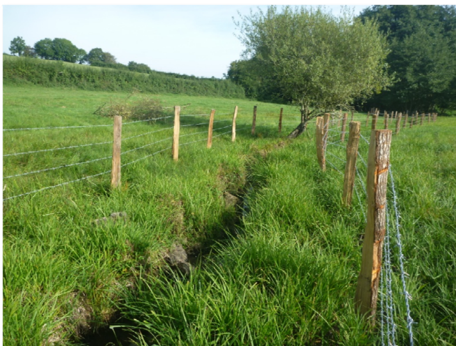
Photo 9 : Installation d'une clôture sur les deux berges d'un cours d'eau du Morvan pour favoriser le retour de la ripisylve. Source : Laure JOUGLARD
