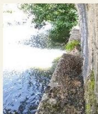
Avant la pose
