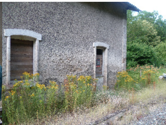
Façade côté sud, après travaux
