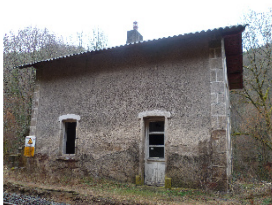
Façade côté sud, avant travaux
