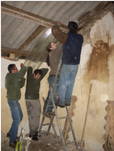
Pose d'une tôle transparente pour obturer un trou dans la toiture
