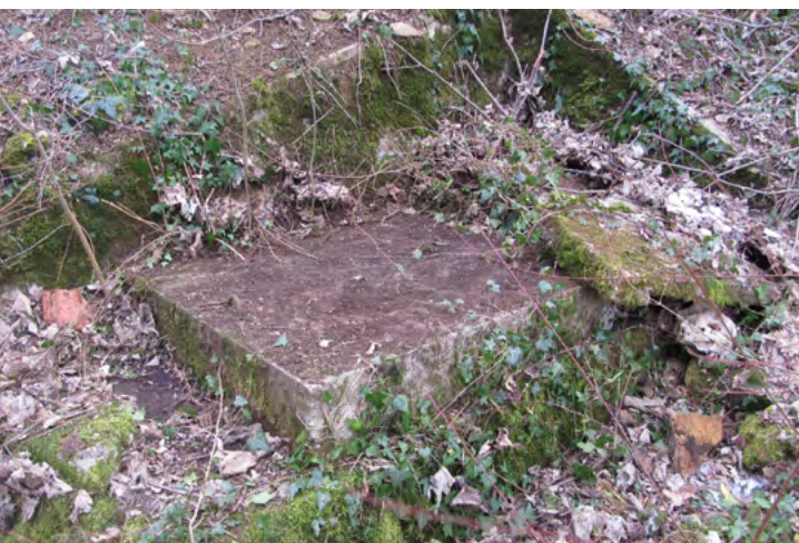
Figure 2 : Dalle en béton obturant le puits d'accès de la mine de fer de Jussey (70) © CPEPESC-FC
