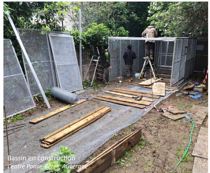
Bassin en construction Montage de l’enclos adjacent Centre Panse-Bêtes, Auvergne
