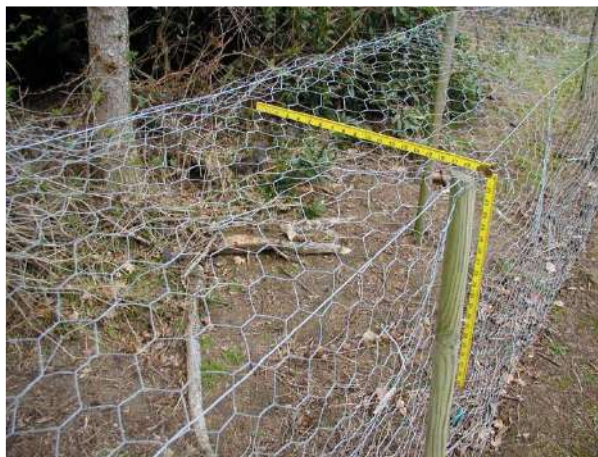
Figure 22 : Débord horizontal vers l'extérieur (MARTIN 2007).
