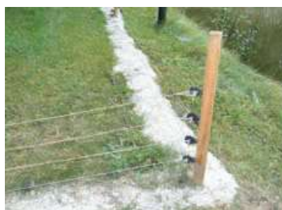
Figure 14 : Série de 4 fils électrifiés espacés de 10 cm. La végétation est tondue ou recouverte (COLLECTIF 2010).
