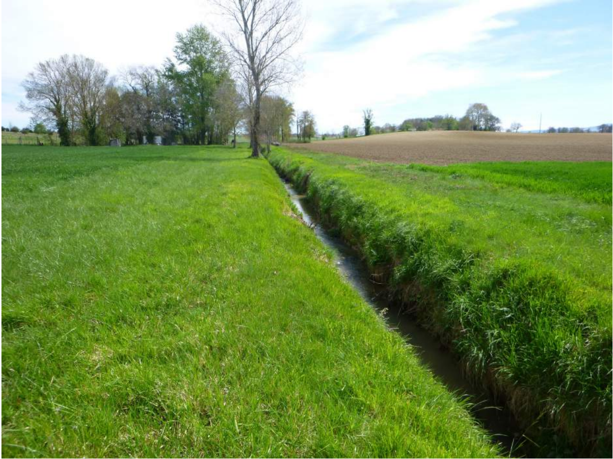
Figure 14 : Exemple de paysage agricole peu favorable au Putois : le cours d'eau a été fortement remanié et est soumis à une érosion importante due à l'absence de végétation sur les berges et de la ripisylve (© Nathalie de Lacoste & Nature en Occitanie).
